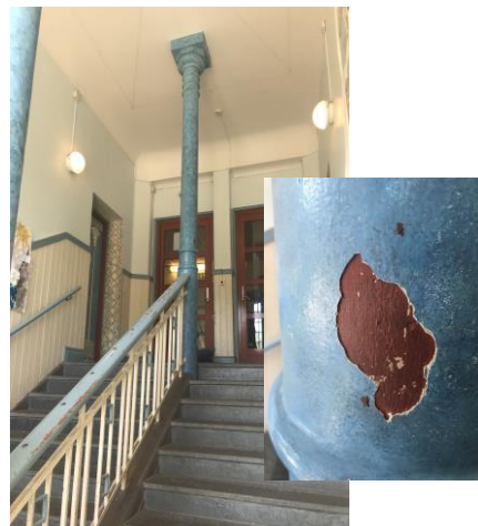
Renovering av trapphus (Krokslättskolan)
